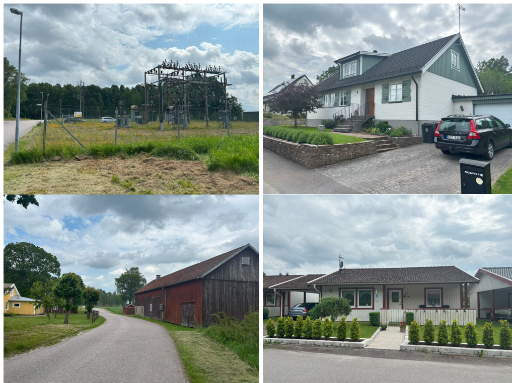
Figur 8. Befintliga byggnader i närheten av planområdet. Bild uppe till vänster redovisar befintlig regionnätstation i direkt anslutning till planområdet. Övriga bilder redovisar villabebyggelse och ladugårdsbyggnad norr om området.
