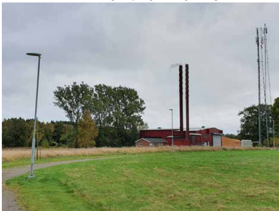
Värmeverket ligger idag mitt i rekreatiomsområdet Stallaholm.
