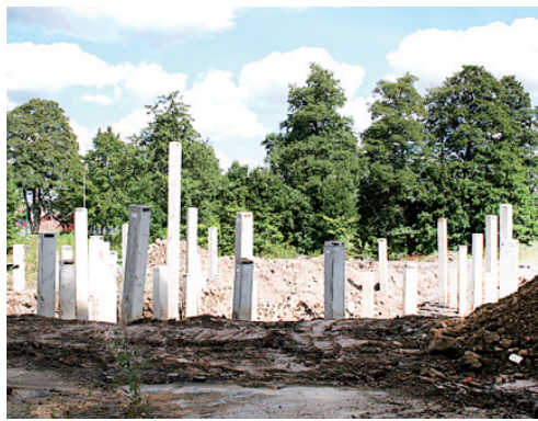
Pålning pågår för att ge höghuset en stabil grund att stå på.
